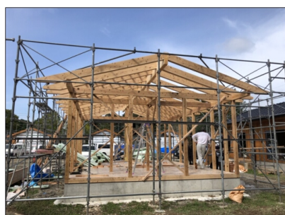
▲建築中の仮設住宅の様子
